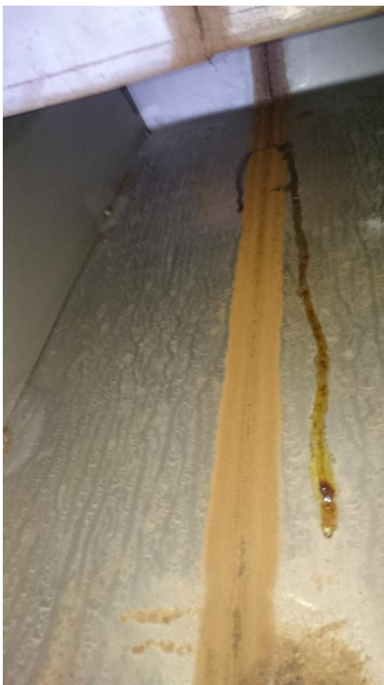
Figur 11. Gjennomgående hull i plate.
