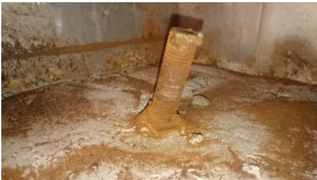
Figur 16. Ende av det som antas å være en forspennings-stang med mutter.
