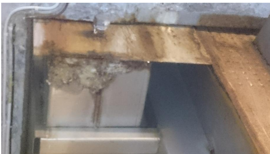
Figur 8. Avløpsboks på firkantkanal.
