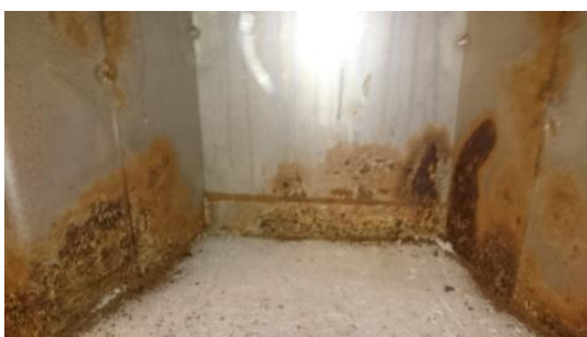
Figur 3. Stivere med overflaterust.
