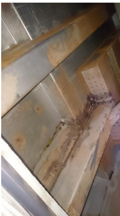
Figur 9. Avløpsboks på firkantkanal.
