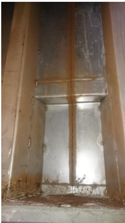
Figur 2. Plate og 2 vertikale stivere. Stiverne er punkt sveiste med gode sveiser. Nederst sees en del sprut og støv fra sveising. Ellers sees tydelig den vertikale sveis mellom platene med overflaterust.
