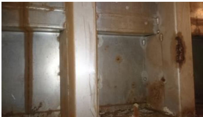
Figur 10. Brennmerker på stiver til høyre.
