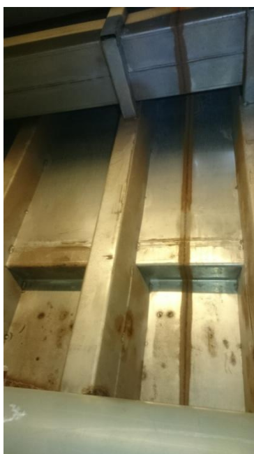
Figur 7. Typisk vertikal sveis mellom plater.
