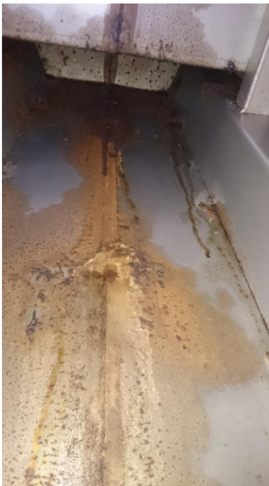
Figur 12. Gjennomgående hull i plate.
